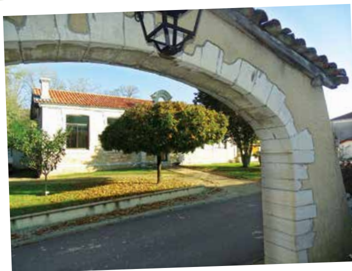
Rénovation de la toiture de la bibliothèque et du musée 2024
